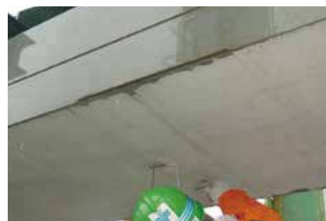
ひび割れ確認状況
