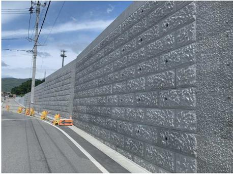
構造用垂直積み上げ式擁壁
