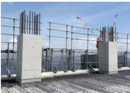
ザ・タワー横浜北仲 (柱セット状況)
