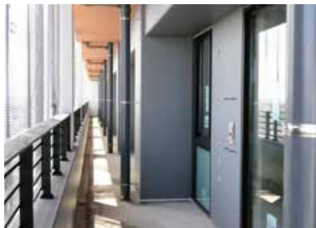
ザ・タワー横浜北仲 (仕上状況)
