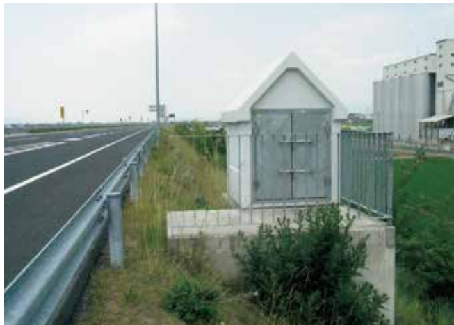
発注者：東日本高速道路(株) 東北支社 設置場所：東北中央自動車道 山形中央I.C
