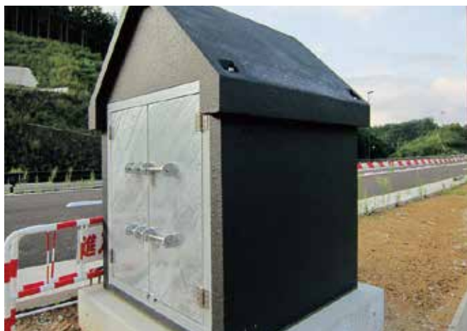
発注者：国土交通省 中国地方整備局 設置場所：山陰道 仁摩温泉津道路
