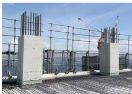
ザ・タワー横浜北仲 (柱セット状況)
