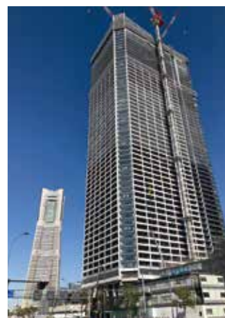
ザ・タワー横浜北仲 (工事全景)
