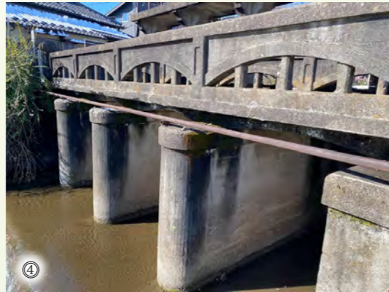
写真① 河内川橋(筆者撮影)
