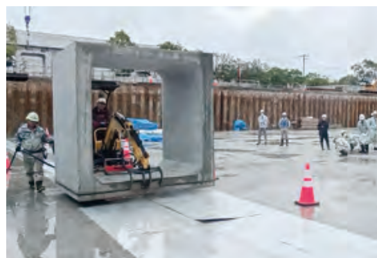
エアキャスター工法にて据付
