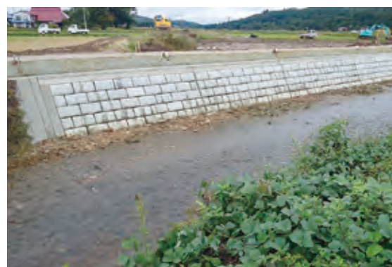
川西町内河川災害復旧工事
