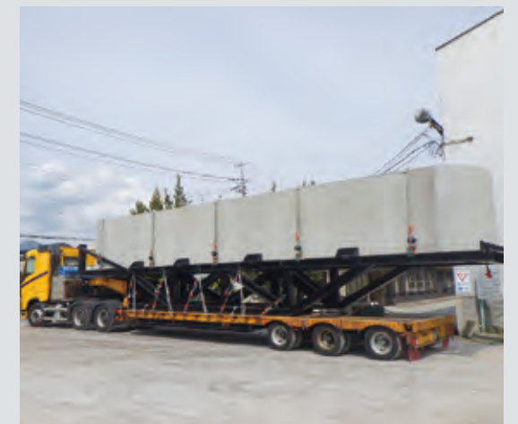
橋脚用高耐久性埋設型枠SEEDフォームの函体出荷 (鉄骨コンクリート複合構造橋脚(REED工法)での橋梁下部工事)
