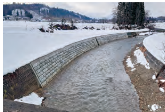
川西町内河川災害復旧工事
