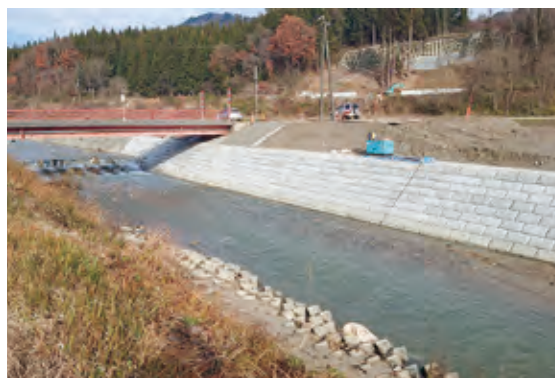
飯豊町内災害復旧助成工事
