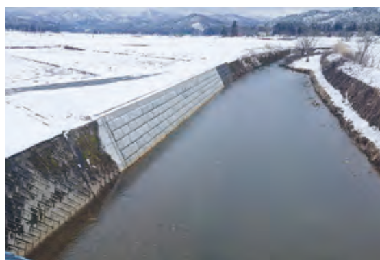
川西町内河川災害復旧工事
