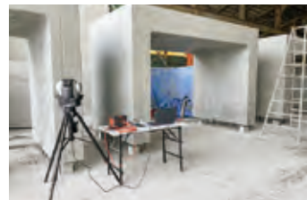
① カメラユニットを設置
