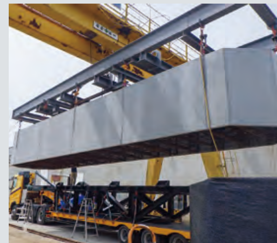
橋脚用高耐久性埋設型枠SEEDフォームの函体出荷 (鉄骨コンクリート複合構造橋脚(REED工法)での橋梁下部工事)
