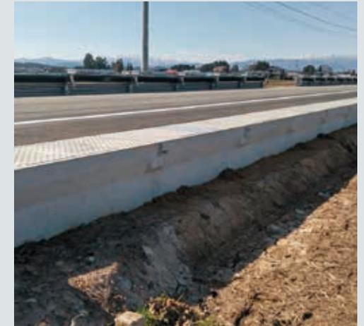
(側溝土留工法)ジオセル土留工法
