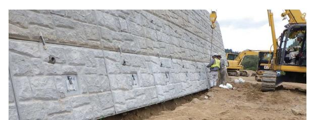
PANWALL 工法は逆巻き施工を基本とした安全性の高い工法で、法面を上から下へ 1 段ずつパネルを設置・補強材を打設し、すべり崩壊と法面保護を同時に行う事が出来ます
