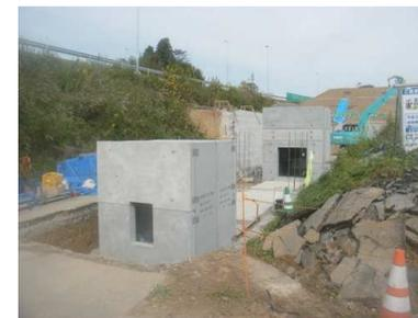
駐車場の雨水排水整備工事で、当初現場打ちで設計されていた大型放流塔をボックスカルバートの型枠を利用し、大型分割枠として施工しました。工場での生産を行うことにより、不足している型枠工・鉄筋工を補い、工期の短縮にも大いに貢献できました。
