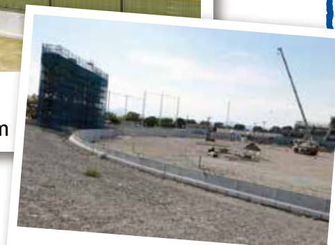
工事中の外野フェンス擁壁
