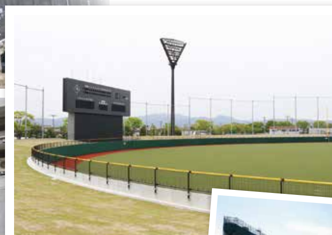
外野フェンス擁壁 高さ3000mm／延長187m
