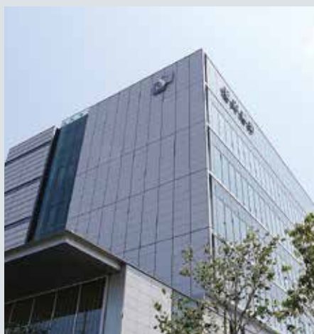
(PCa石打込みカーテンウォール) 山形県 鶴岡市 荘内銀行本店工事
