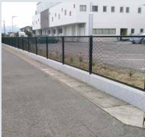
(化粧付境界ブロック擁壁 シキール) 山形県 中山町 中山中学校外溝工事
