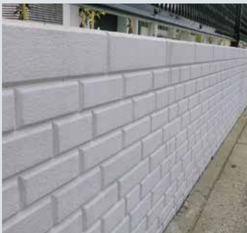
(化粧付境界ブロック擁壁 シキール) 山形県 中山町 中山中学校外溝工事
