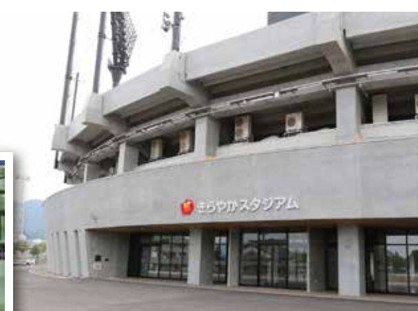
スタジアム外側カーテンウォール
