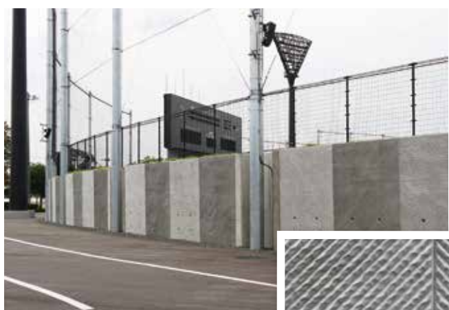
外野外周デザイン擁壁 高さ4000mm／延長152m
