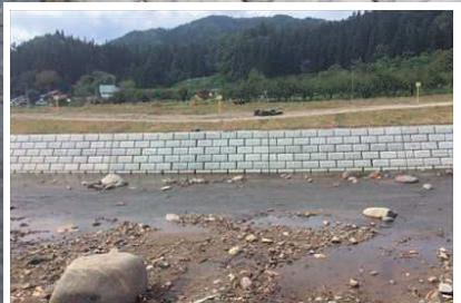
平成25年7月の豪雨、平成26年7月の台風と梅雨前線の影響により市街地などで浸水被害が発生し、吉野川金山工区においても甚大な被害がありました。災害関連緊急対策で短期間(4年間)に集中的な改修が始まり、その一端として護岸改修に練積みブロック（あさひIII型）が採用されました。このブロックは鉄筋による横連結構造となっており水平積みでカーブ施工がスムーズに行えます。50形を使えば裏コシが不要となり施工性に優れ、ブロック表面は擬石模様となっており周囲の景観によく調和した出来栄えとなっております。
