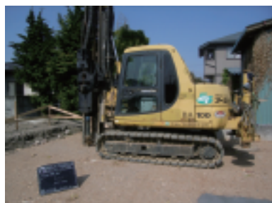
■H パイル打込みマシン
