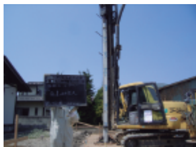
■H パイル打込み作業
