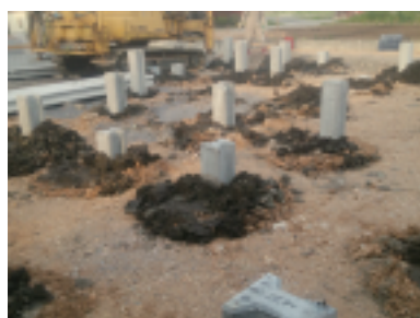
■H パイル打込み後
