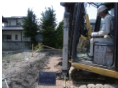
■H パイル打込み作業
