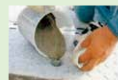
蓋のアンカー筋孔に。
