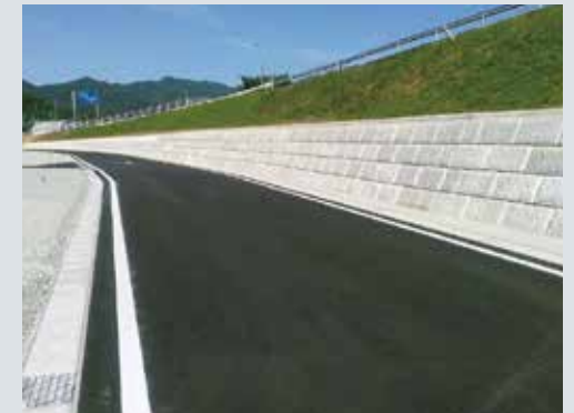
(練積みブロック「あさひⅢ型」) 山形県 天童市 分譲地開発造成工事
