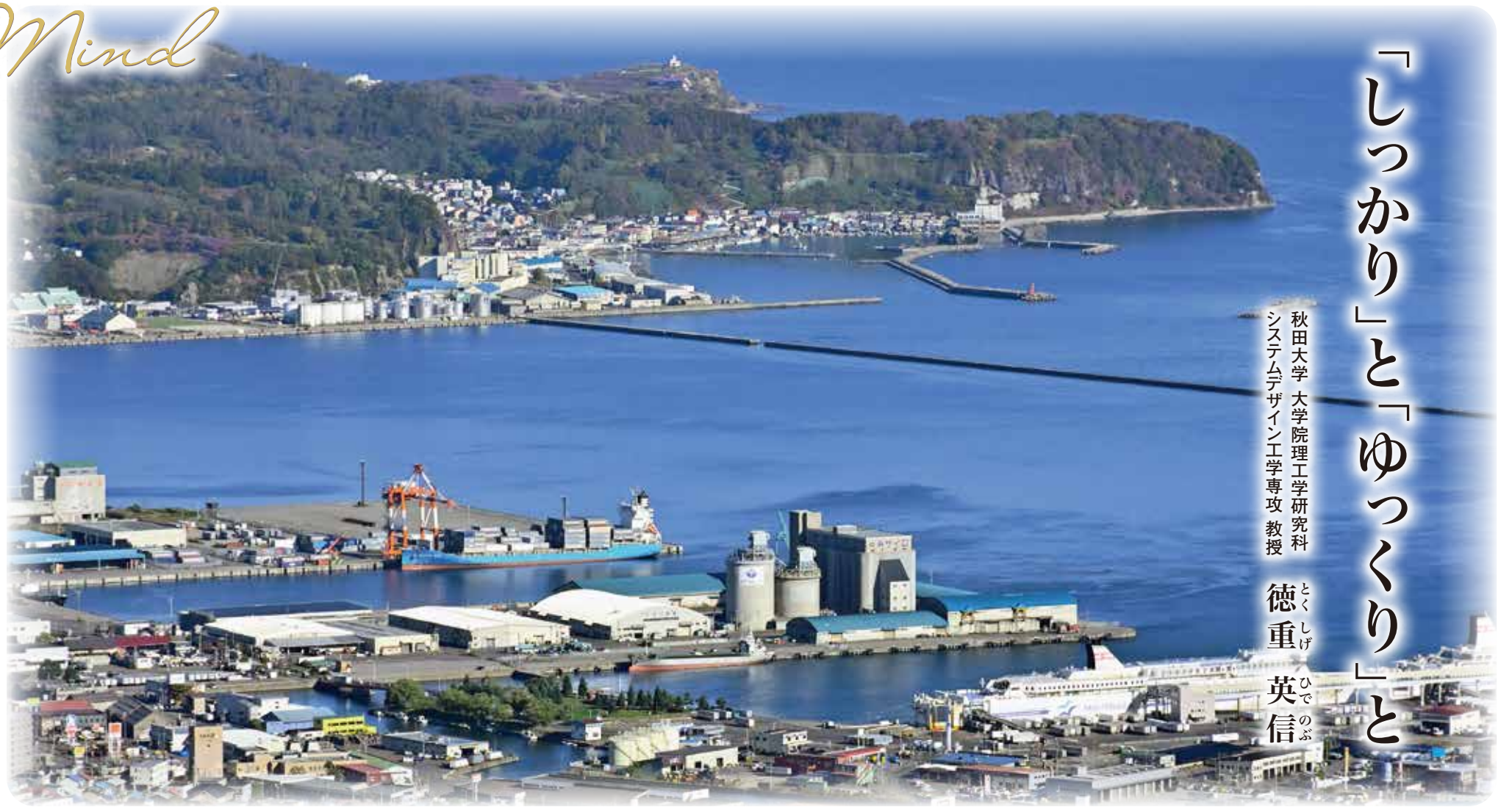
▶小樽港北防波堤
